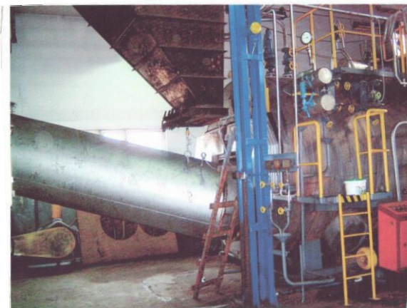
Rys.5. Wyprowadzenie spalin do kotła odzysknicowego.
