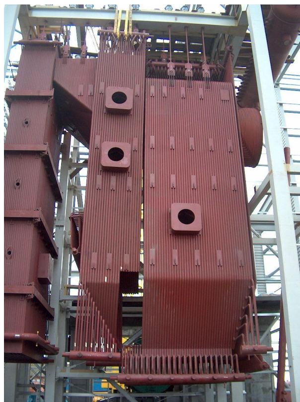
Rys.6. Komora fluidalna.
