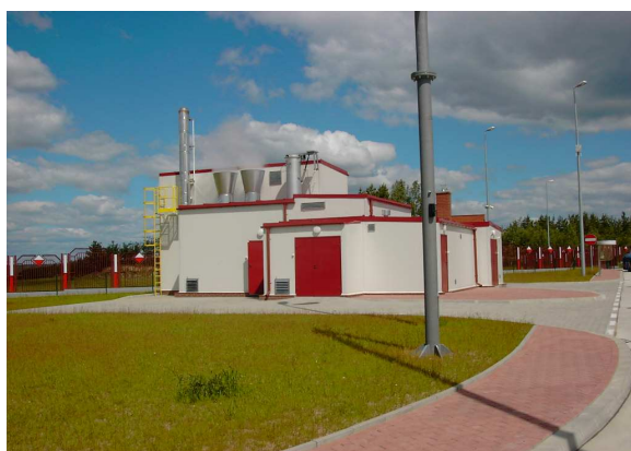
Przykład instalacji do produkcji energii z odpadów ENTECH pracującej od 2003 roku w Kuźnicy Białostockiej
